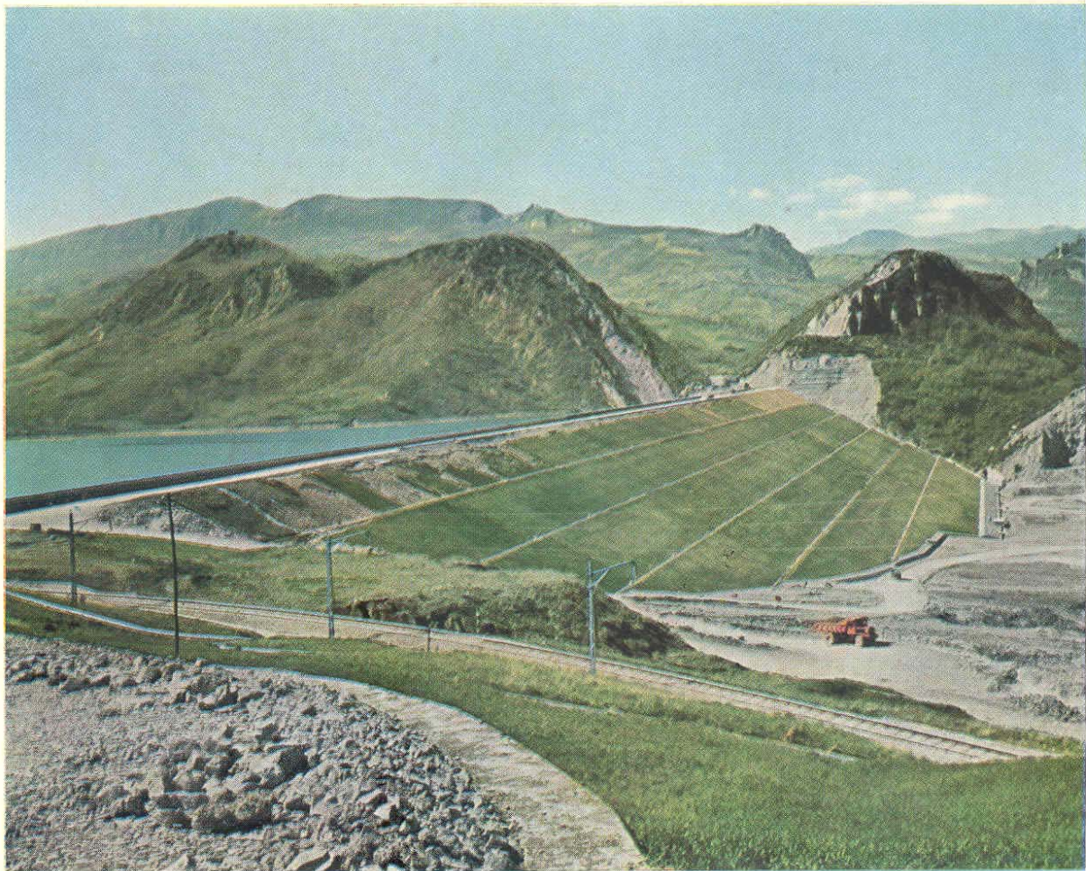
Fig. 18 - DIGA DI BOMBA — L'opera ultimata vista dalla sponda destra.
