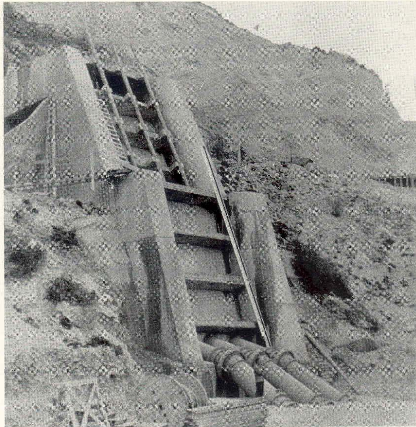
Fig. 32 - SERBATOIO DI BOMBA — Sistemazione dell'opera di presa utilizzata come vasca di carico nell'esercizio provvisorio di sollevamento con pompe.
