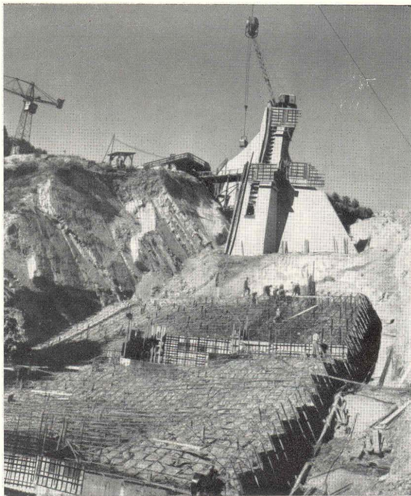
Fig. 13 - DIGA DI CASOLI — Base degli zoccoli in calcestruzzo armato.
