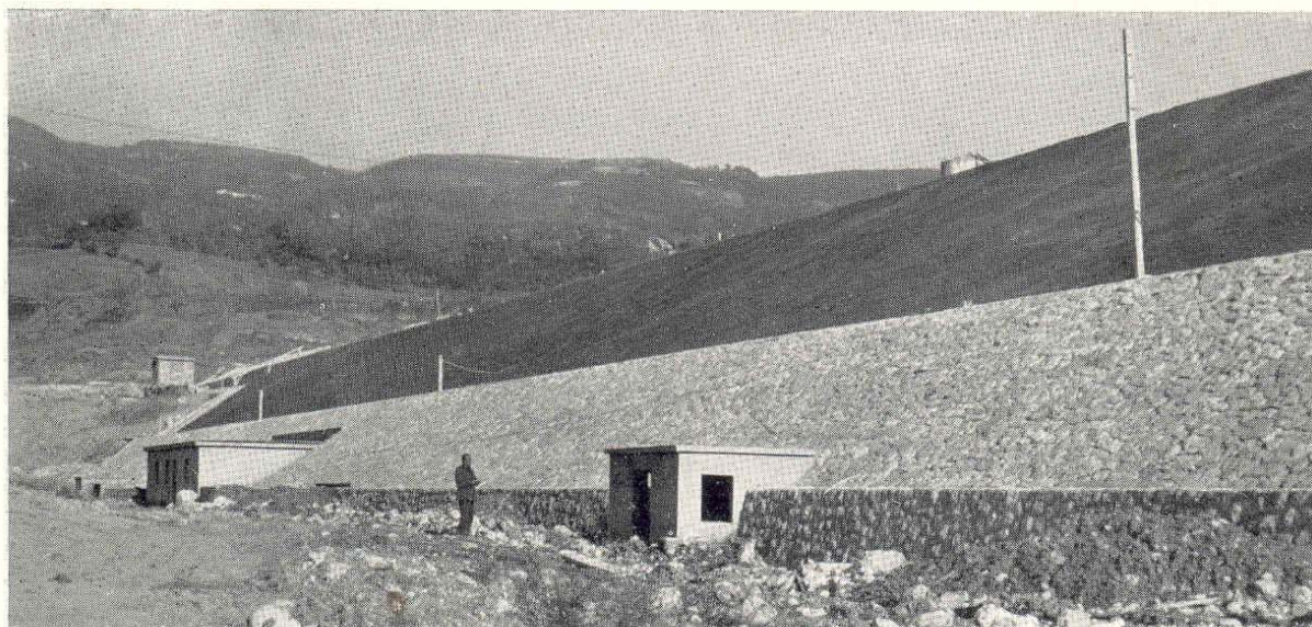
Fig. 24 - DIGA DI BOMBA — La diga costruita fino alla q. 225. Al piede, nella zona centrale, è visibile la cabina di misura.
