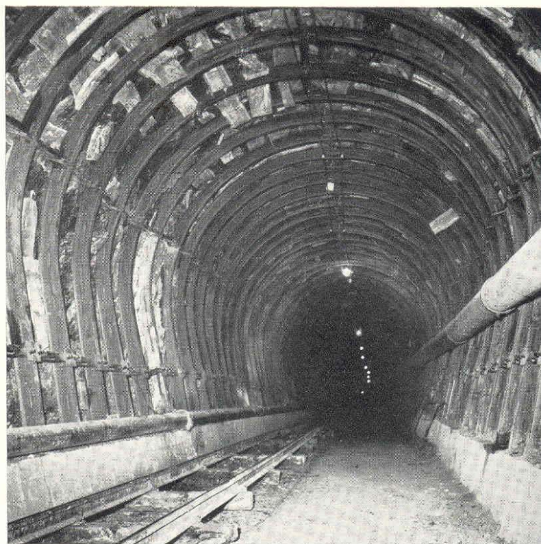
Fig. 36 - Centine a ferro di cavallo impiegate nella costruzione della galleria di derivazione dal Sangro.
