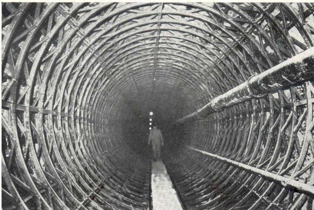
Fig. 35 - Centine metalliche di tipo reticolare impiegate in un tronco sperimentale della galleria di derivazione del Sangro.
